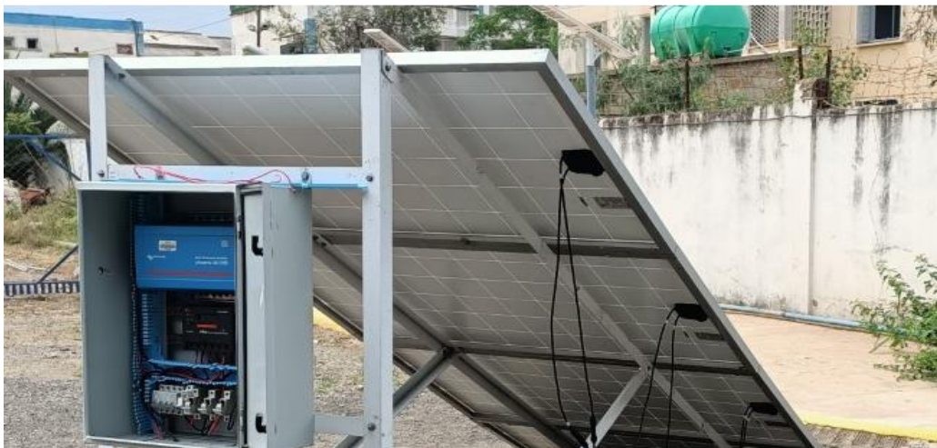
Figure 2- 5 Fixation des panneaux et de l'armoire
