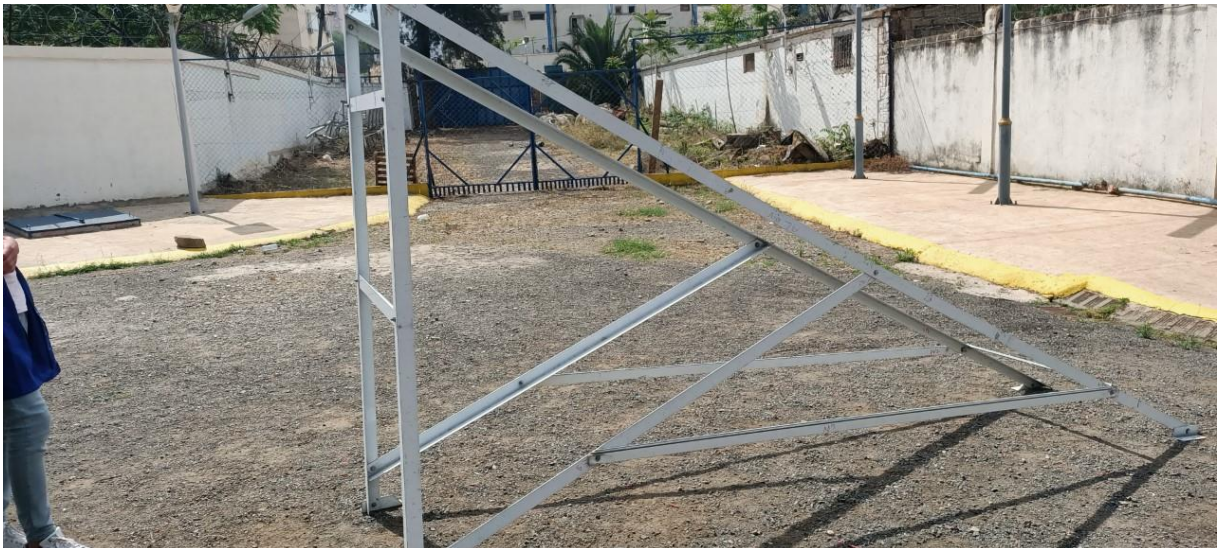
Figure 2- 4 Dépôt de la structure porteuse
