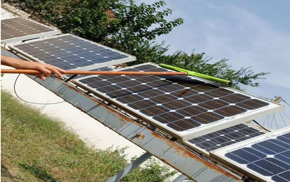
Figure 3- 2 Nettoyage des panneaux solaire
