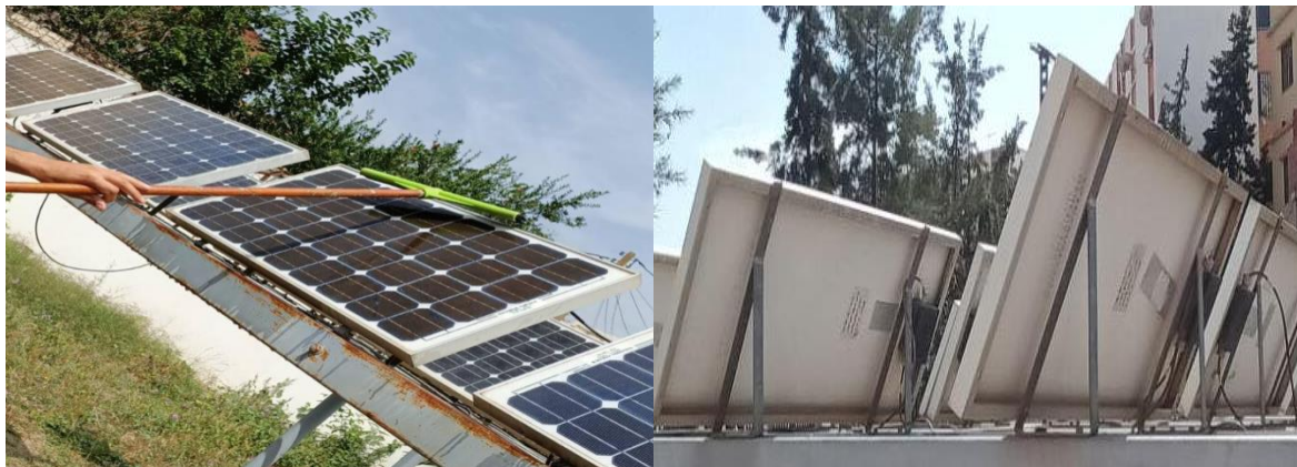
Figure 3- 5 Nettoyage des panneaux et vérification de structure
