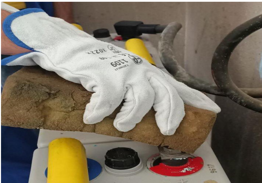
Figure 3- 7 accumulation de saleté dans les bornes de batterie
