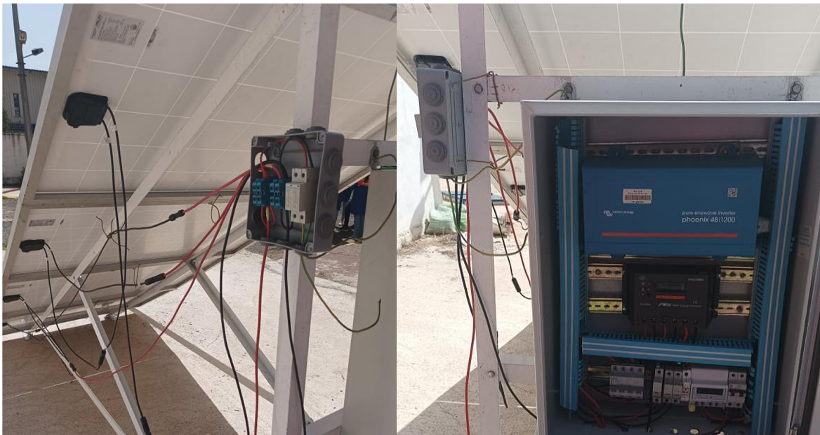
Figure 2- 7 Boîte de raccordement et branchement panneau-régulateur
