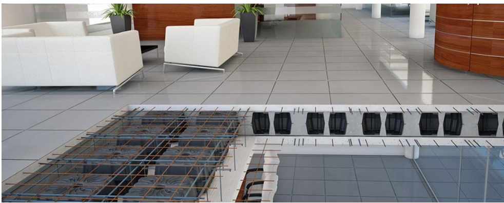
Figure II.1 : Plancher à corps creux.
