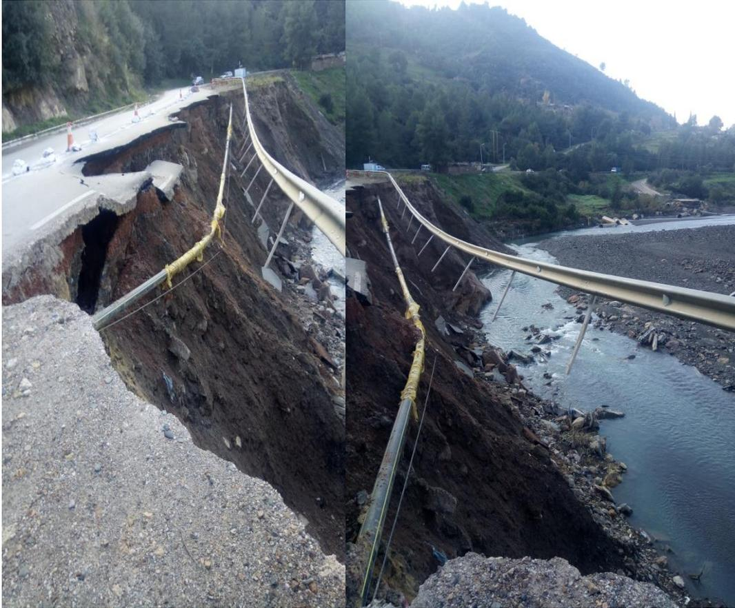
**Figure II. 7:** Destruction de la chaussée du côté aval de la route.
