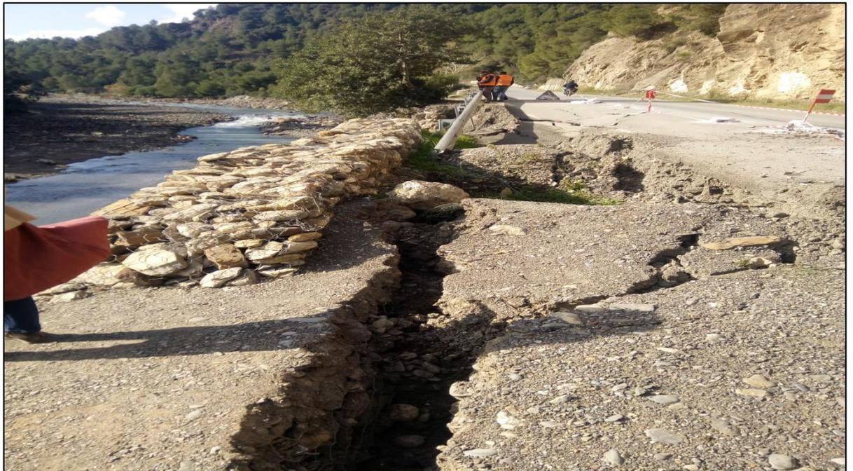
**Figure II. 6:** Grandes fissuration après le glissement.
