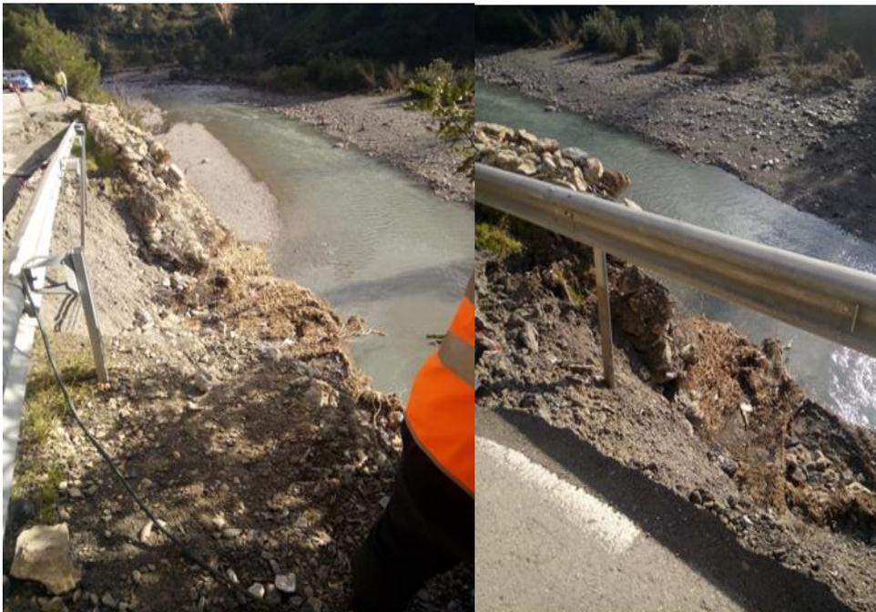
**Figure II. 8:** Instabilité du talus situé du côté aval de la route.
