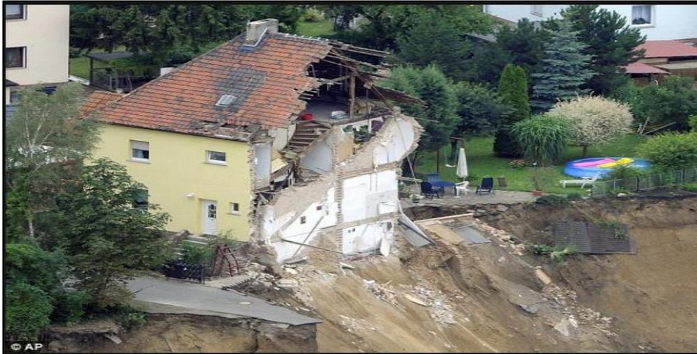
**Figure I. 3:** glissement plan dans le centre de l'Allemagne.
