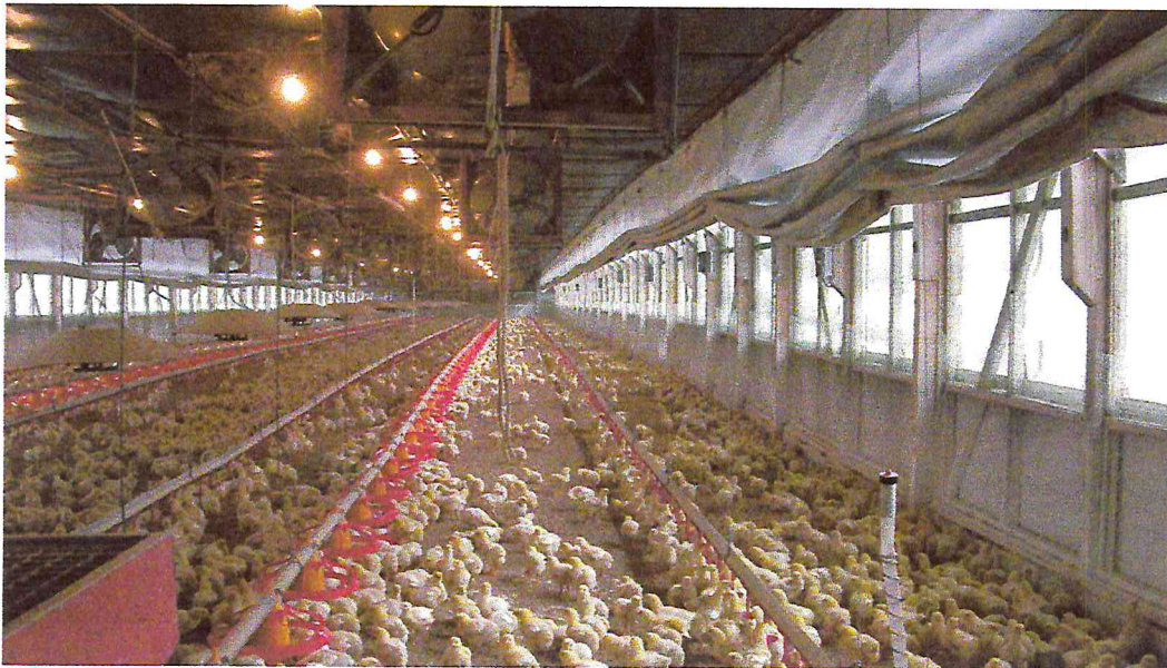
Figure n°1 : un exemple de ventilation statique (Aviagen, 2010).
