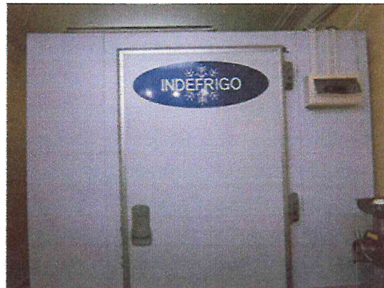
Figure 8 : Chambre frigorifique en acier inoxydable (Vue extérieure) (Photo personnelle)
