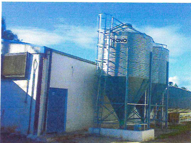
Figure n° 11: Silo de stockage et distribution d'aliment.
