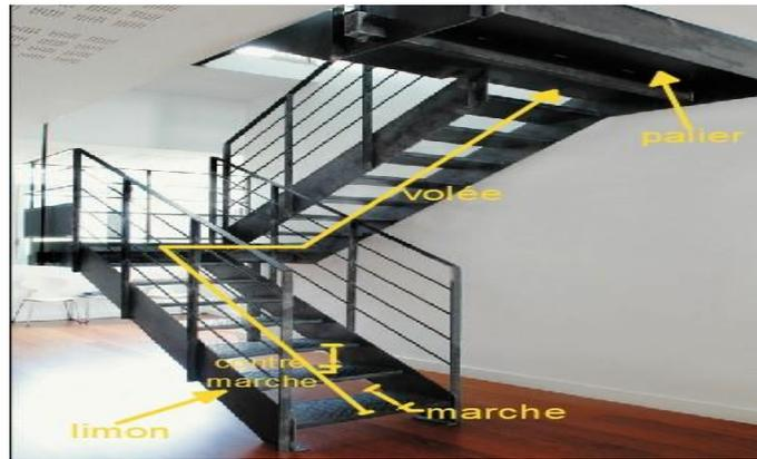
Figure 3 2: Les éléments structuraux d'un escalier
