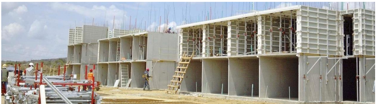
Figure I.3 : Contreventement en voile
