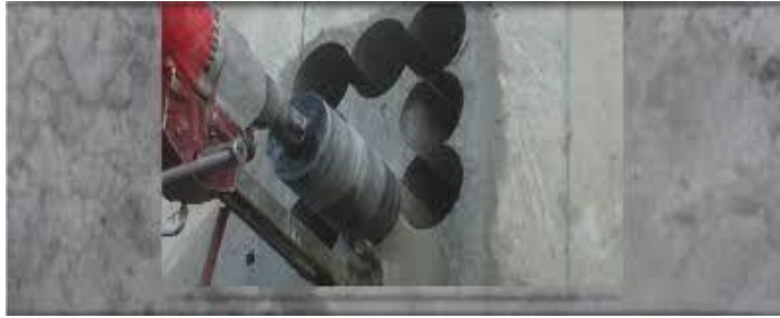
Figure I.19 :: Le carottage de béton
