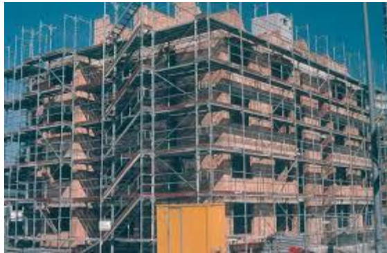
Figure I.2 : Remplissage en maçonnerie
