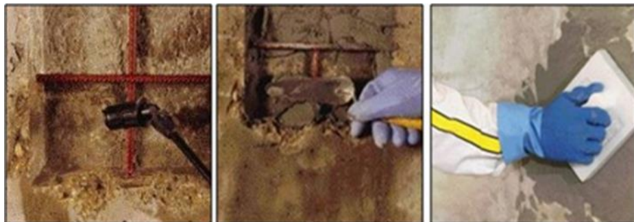
Figure II.2 : Gauche à droite; Aciers dégagés, Application du mortier, Finissage par taloche
