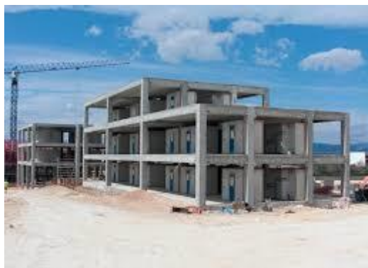
Figure I.1 : contreventement par portique
