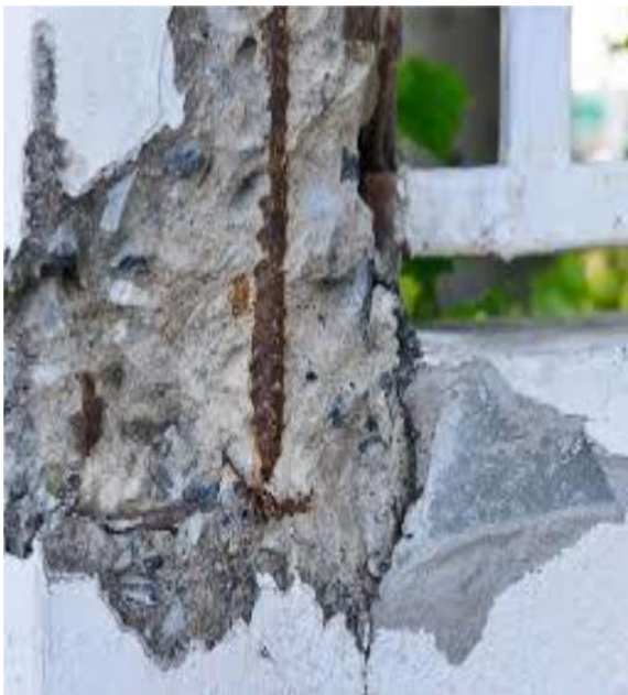
Figure I.8 : carbonatation de béton.
