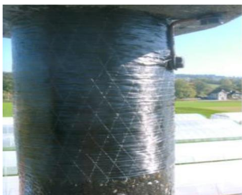
Figure II.8: poteau confiné par TFC[18].
