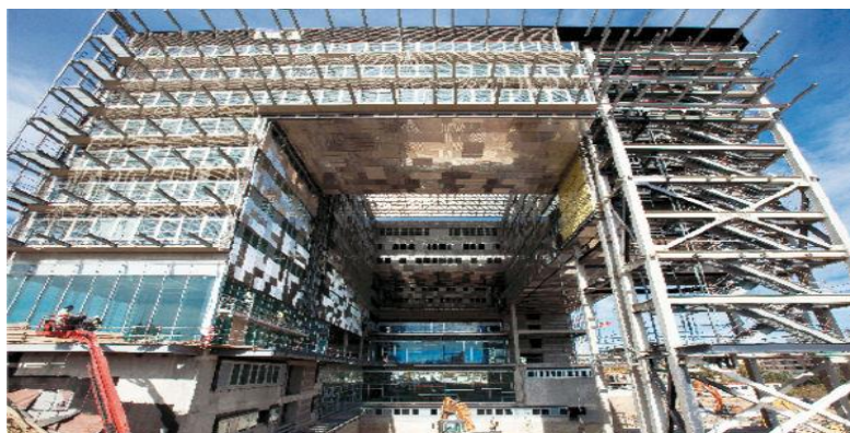
Figure I.4 : Contreventement par portique auto stable
