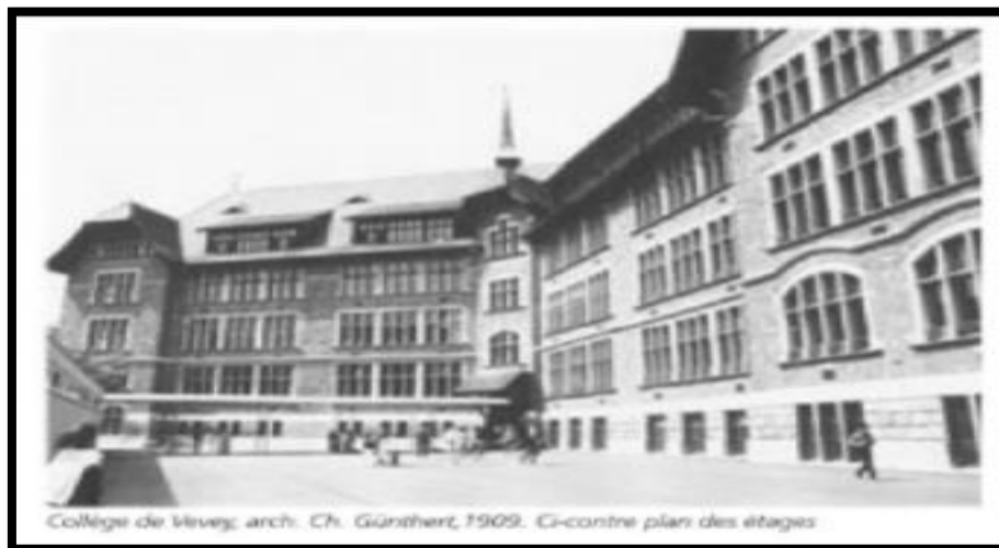
Figure 9: façade d'un bâtiment scolaire à typologie Heitmatstil.
