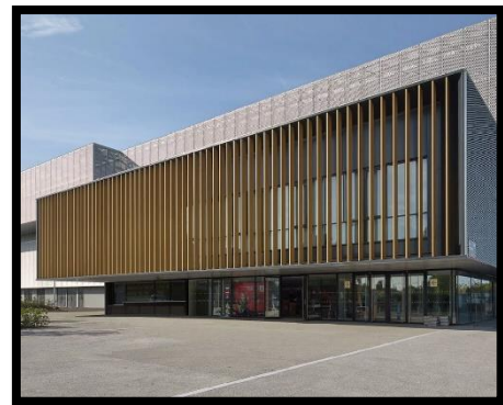
Figure 11: brise de soleil vertical en bois
