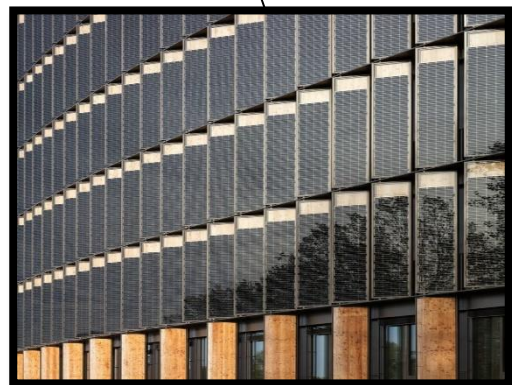
Figure 13: panneaux photovoltaïques dans façade
