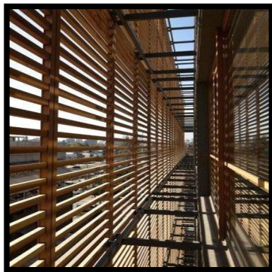
Figure 10: brise de soleil horizontale en bois
