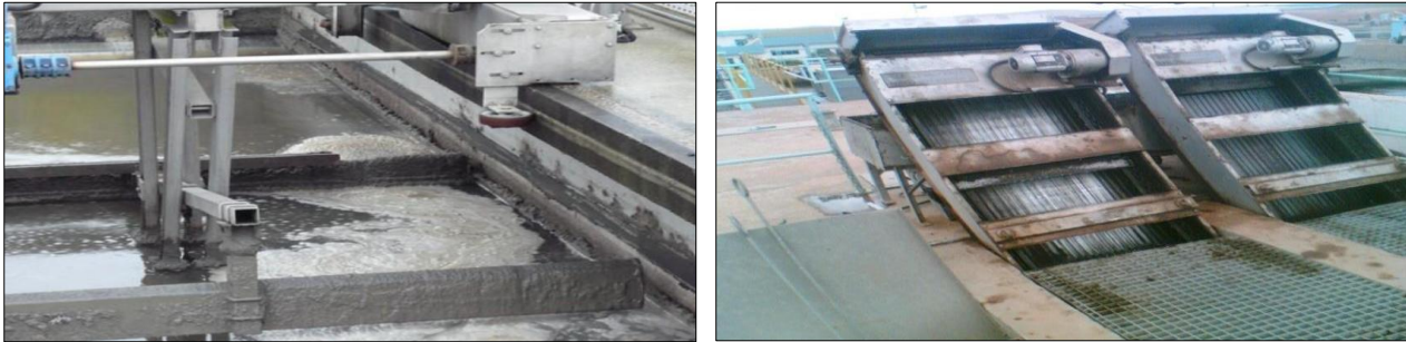
Figure II.1 : Dégraissage et Déshuilage (Station de B.B.Arreidj) [18]
