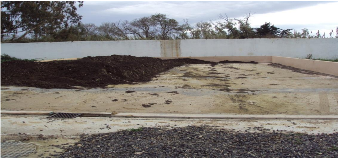
Figure III.5 : Décantation au niveau de l'épaisseur au niveau de la station d'épuration de chenoua
