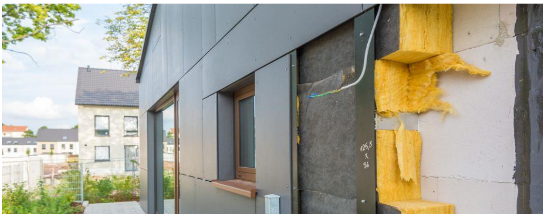
Figure 11: image réelle d'une réalisation d'un mur à isolation extérieure [16]
