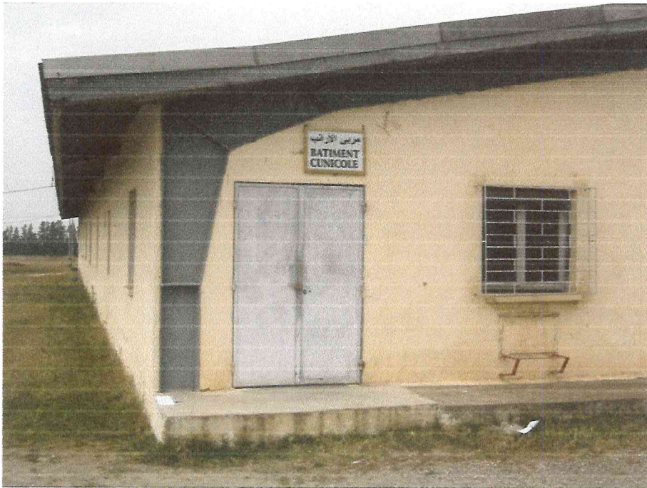
Figure 5: Le bâtiment cunicole de la station expérimentale.
