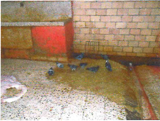
Figure n°7 : Etat du sol et murs.
