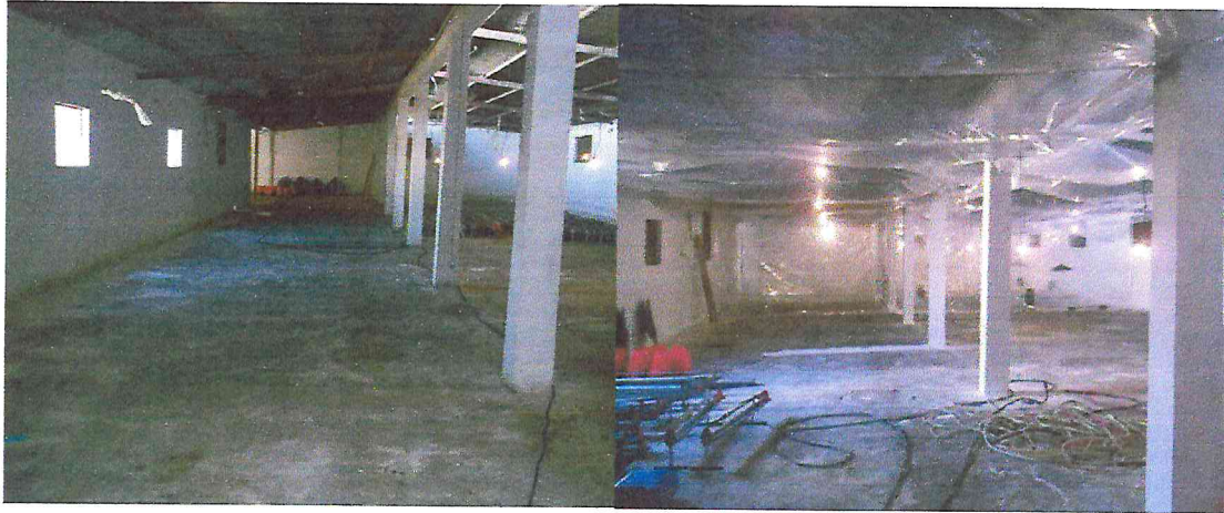
Photo N°11 : Bâtiment avant et après le nettoyage.
