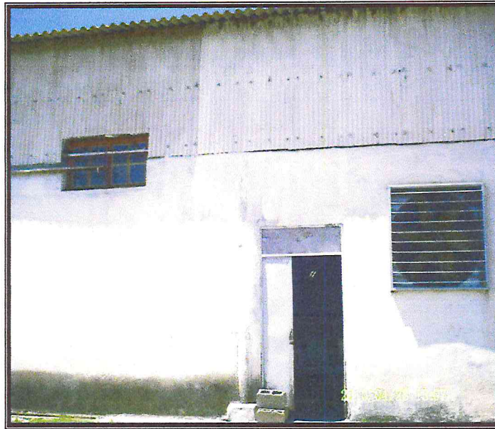
Figure 11: Le bâtiment d'élevage de Tizi Ouzou (Photo personnelle).
