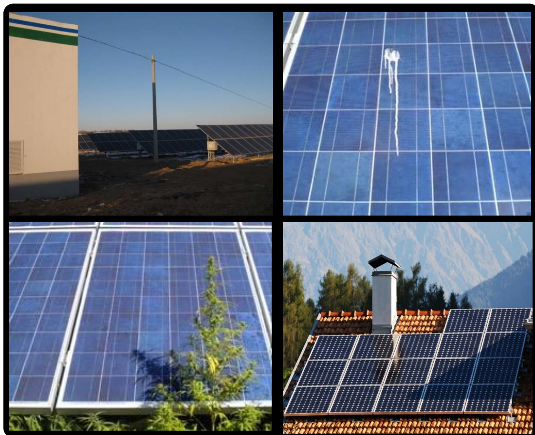
Figure II. 5: L'ombrage dans les applications BIPV.
