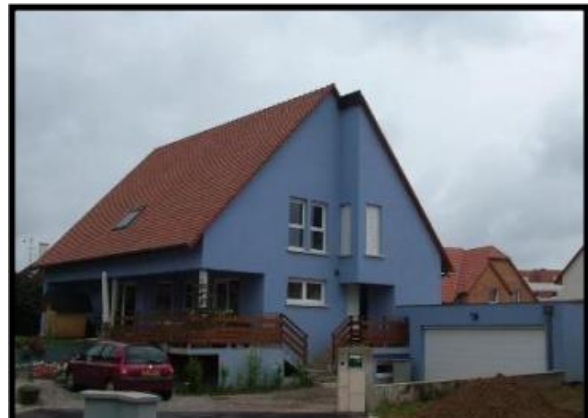
Figure-22 : Maison individuelle à SOUFFELWEYERSHEIM Source : https://www.hkarchitecture.fr/individuel.php
