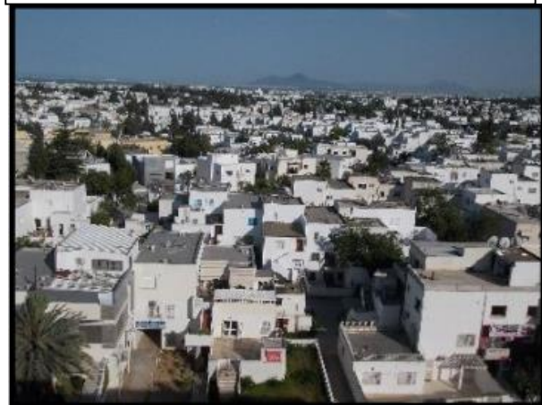
Figure-23 : Vue aérienne sur l'habitat semi-collectif en Tunisie/Source : https://www.alsabil.tn/?p=438
