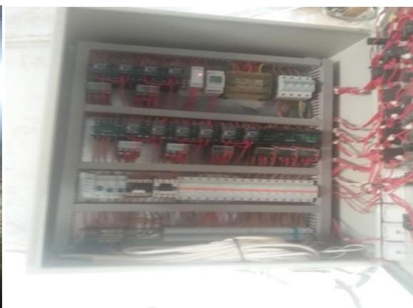
**Figure n°11** : l'éclairage du bâtiment      **Figure n° 12** : panneau de commande l'éclairage
