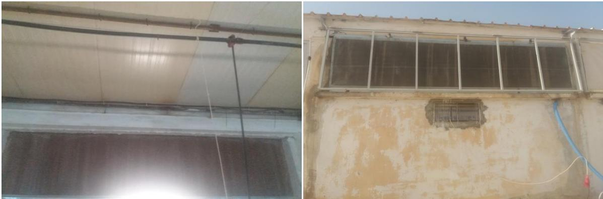
**Figure n° 09 :** Le système d'humidification (photo personnelle., 2021)
