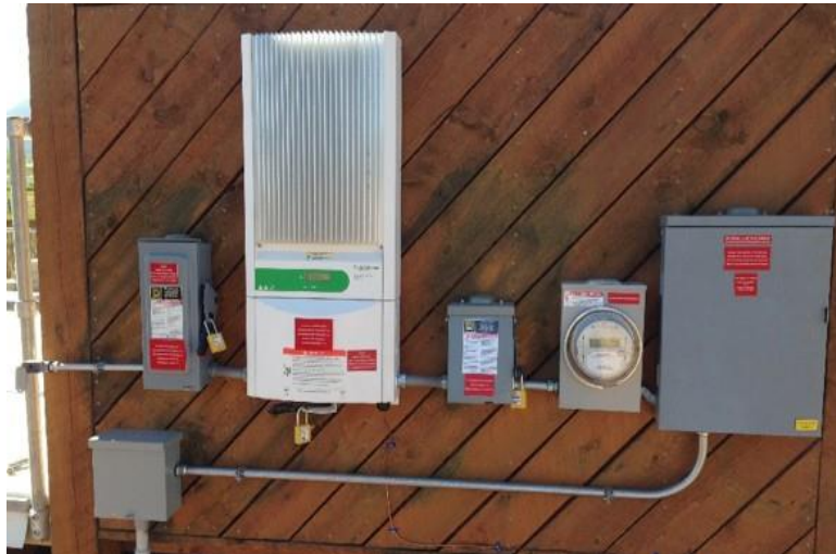
Figure 1- 18 : Système solaire connecté au réseau
