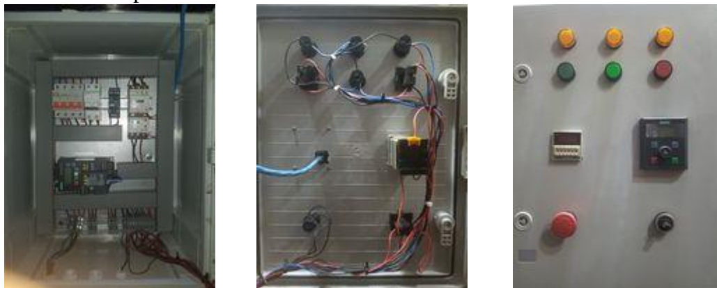
Figure 5.3. Les composants électriques de notre machine gâteaux
