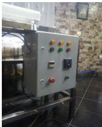
Figure 5.2. Armoire électrique de notre machine gâteaux
