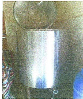
Photos n°21 : cuve propre
