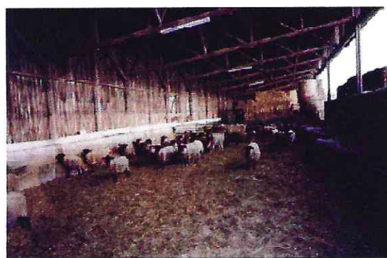
▲ Figure n° 10 Hangar bergerie en bois de l'intérieur www.tnfrance.tableau-noir.net/pages/elevage.html
