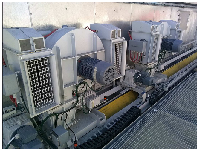
Figure II.2 Ventilateur basse pression sur chariot mobile pour le décolmatage des manches.
