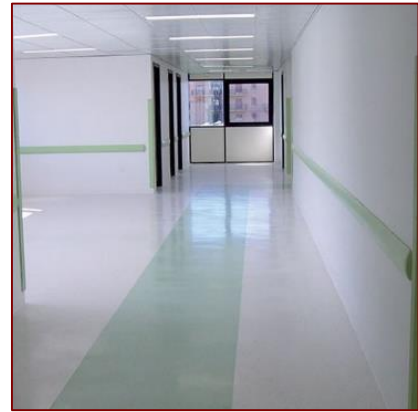
Figure 77 : revêtement en époxy Source : doodle image
