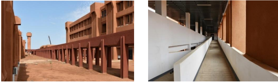
Figure 33 : Vue sur les corridors et les rampes Source : www.archdaily.com
