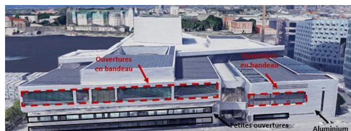
Figure 84 : Façade Est de l'opéra d'Oslo. Source : Google Maps.
