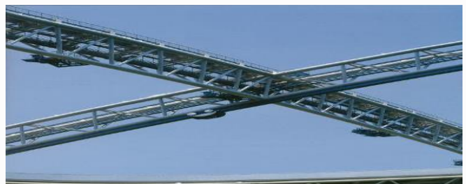
Figure 133 : la jonction entre 2 poutres tridimensionnelles (K)
