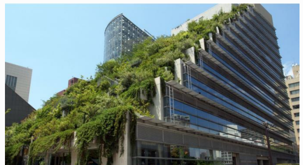
Figure 152 : Toiture végétalisée intensive en terrasse
