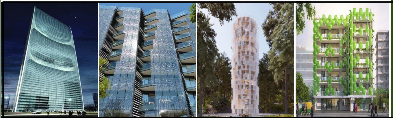
Tour de Rivière des perles Façade verre photovoltaïque
