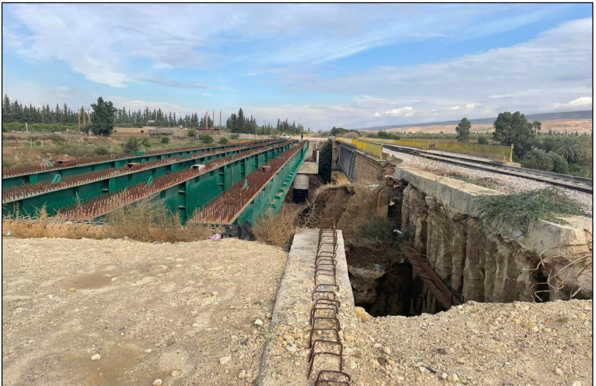
Figure.II.20: Vue en face de la voie en service et nouveau pont.
