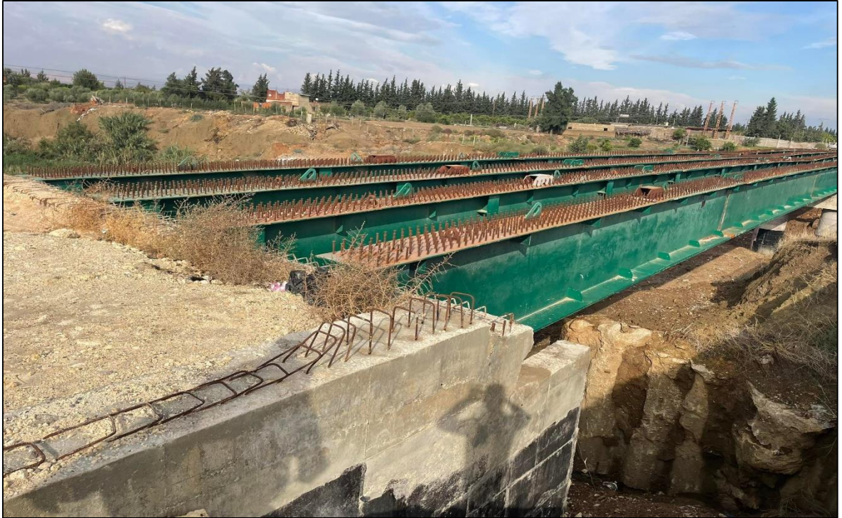
Figure.II.19: les poutres métallique du nouveau pont.
