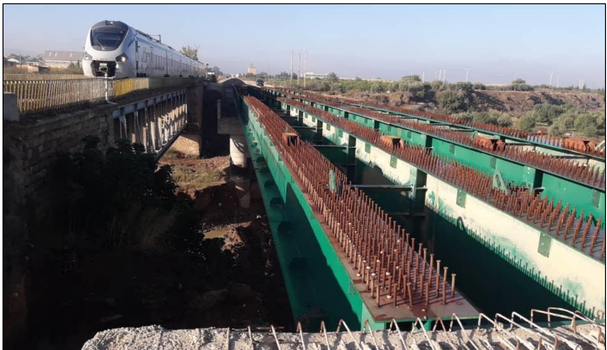
Figure.IV.22: La voie en service et le nouveau pont.
