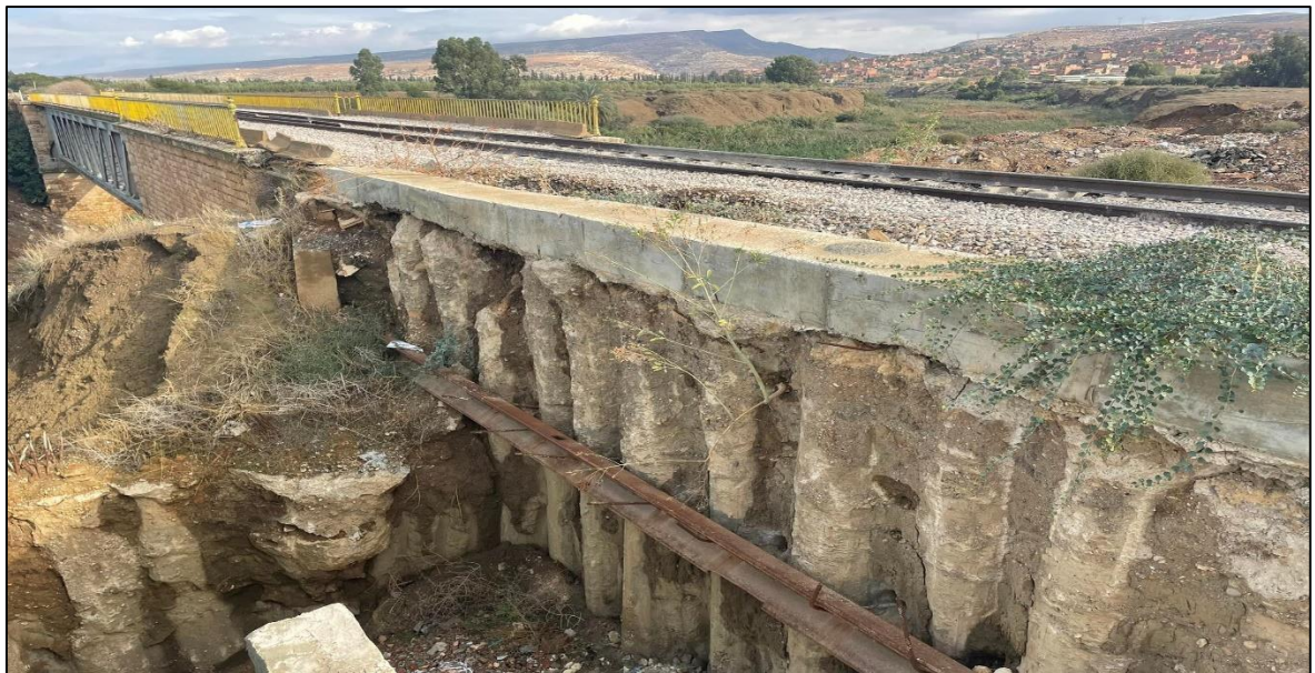
Figure.IV.31:L'écran de soutènement en micro pieux.
