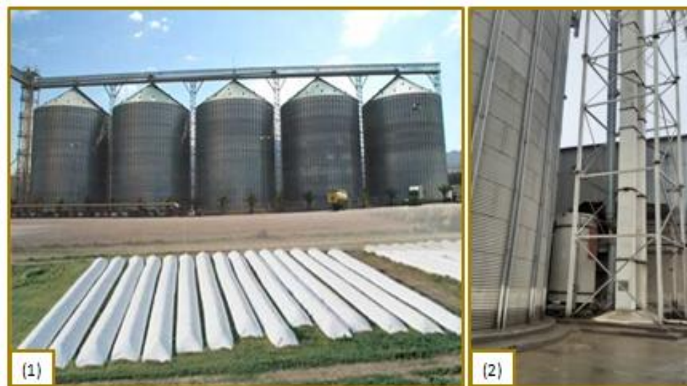
Figure 2: Silos de stockage (1) les silos métalliques / (2) silo métallique avec le rigleur ( Aoues, 2017 ).
