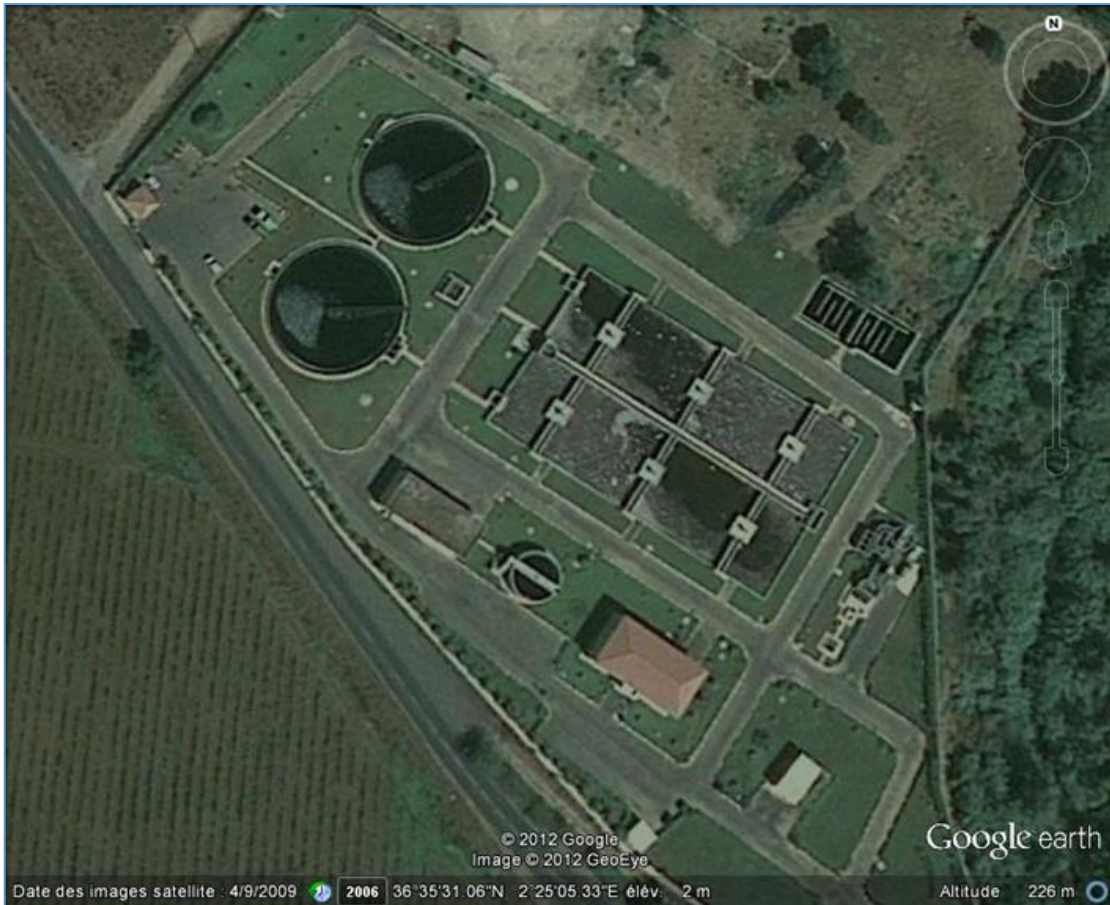
Figure 5. Situation géographique de la STEP (Google Earth).
