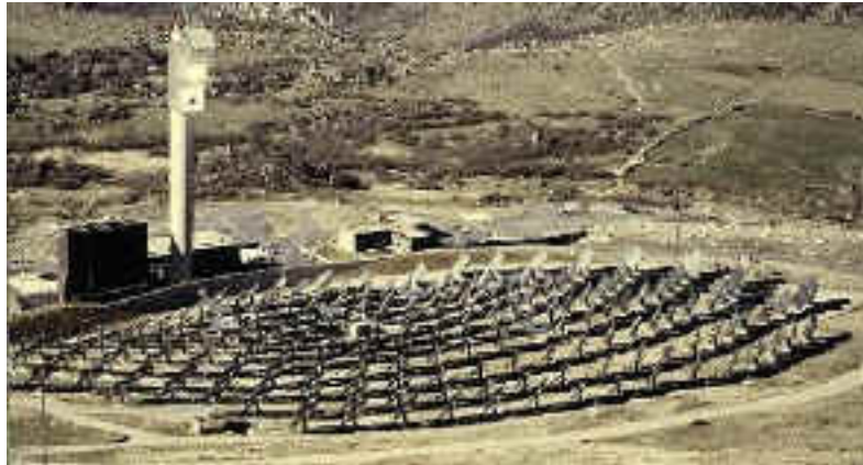
Figure10 : La centrale Thémis sur le site de Targassonne à 1650 m d'altitude, dans les Pyrénées-Orientales
