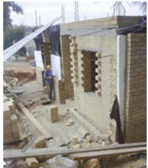
**Figure. 2.9** Isolation des murs extérieurs
