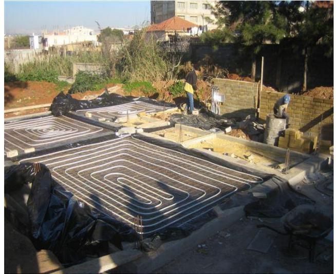
**Figure. 2.8** Emplacement du serpentín lors de la construction
