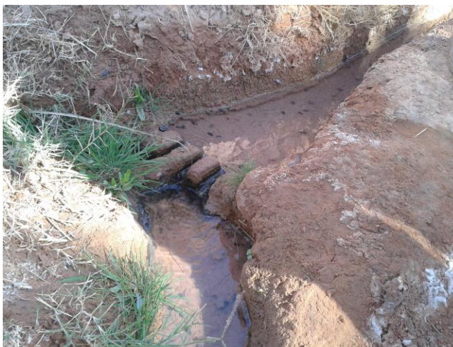
Fig. 1.12. Kasria tertiaire du réseau de distribution dela foggara Djenet Esghar (Aoulef)
