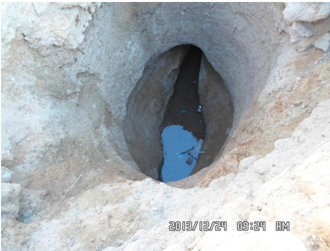
Fig. 1.7. Un puits situé dans la partie transport (faible profondeur) de la foggara de Tifena (Aoulef)
