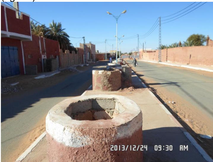
Fig. 1.4. Série de puits : synonyme de l'existence d'une galerie sous le sol (Aouilef)
