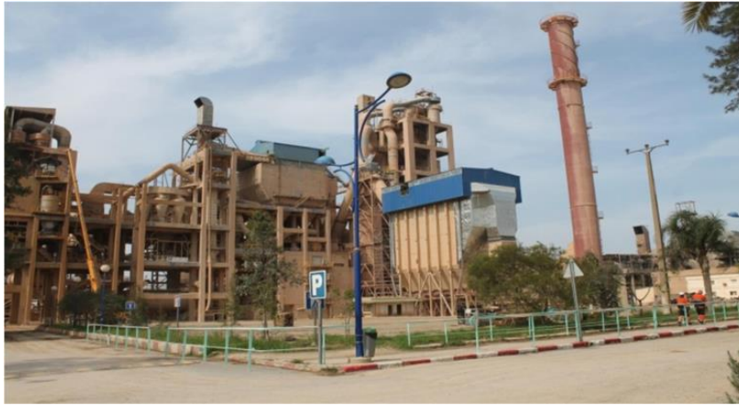
Figure 1.7 : Vue de l'usine de MEFTAH du coté où se fait le prés-broyage et le séchage.
