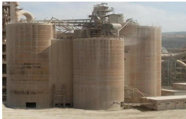
Figure 1.6 : Vue de l'Atelier d'homogénéisation.
