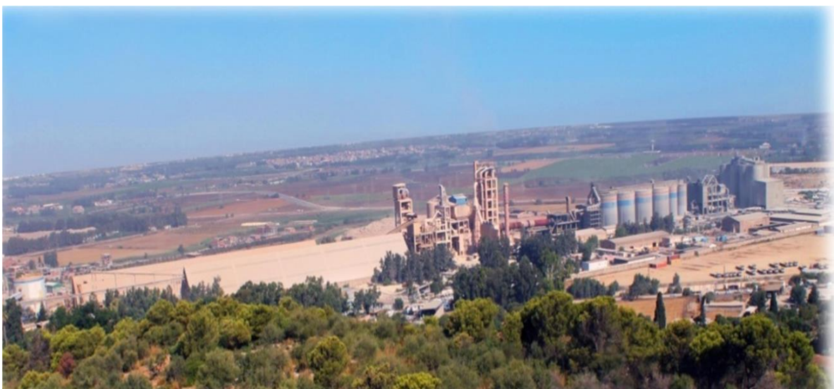
Figure 1.1 : Vue de la cimenterie de MEFTAHA.
