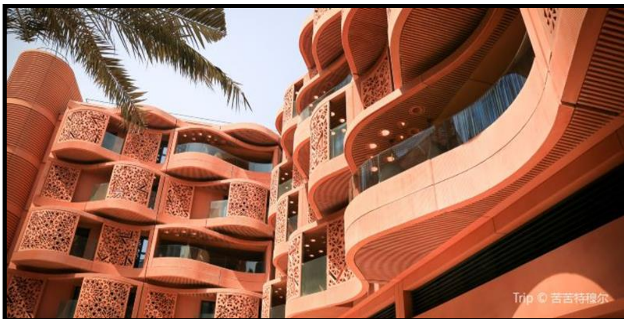
Figure 3.26 : La façade du campus universitaire de la ville de MASDER
