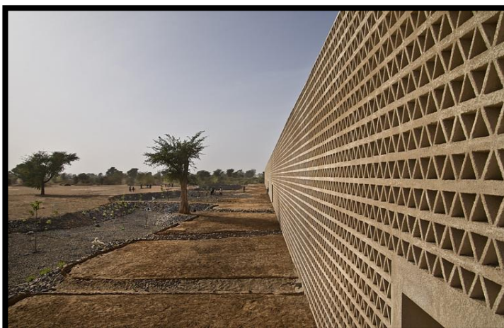
Figure 3.10 : La ventilation naturelle dans les façades dans université Alioune Diop se trouve dans le lien www.akdn.org/fr/architecture consulte le 22-06-2020
