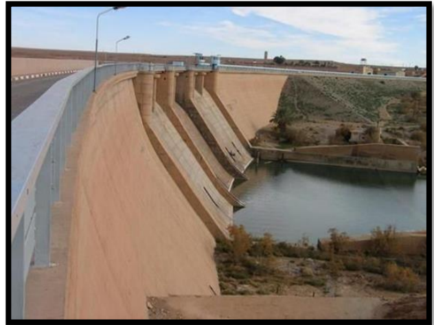
Figure 4.9 : Barrage de Djorf Torfa, à Béchar Source : https://fr.wikipedia.org/wiki/Barrage_de_Djorf_Torfa consulté le 01-07-2020
