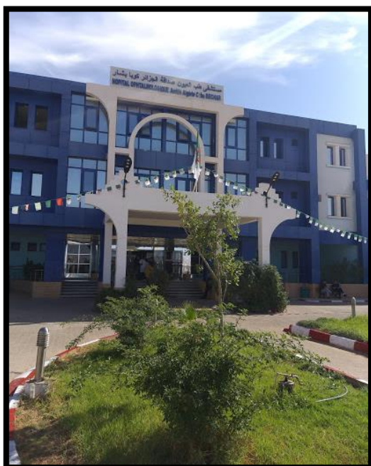
Figure 4.28 : hôpital ophtalmique des KOUBA , équipement du POS SUA1 Source : https://www.facebook.com/EHOBEC HAR/ consulté le 03-07-2020
