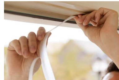
Figure 10 : coupe froid, l'étanchéité du battant de porte "calfeutrage élite"
