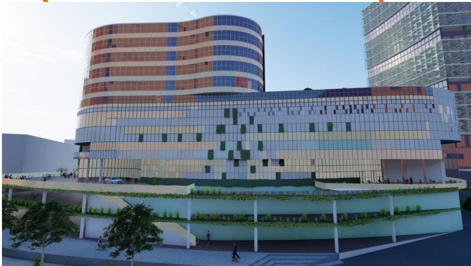
Figure 2. 46: façade Nord ; source auteur
