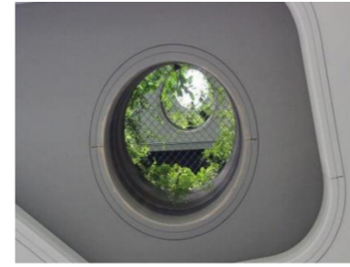
Figure 27: Puits de lumière en porte-à-faux.
