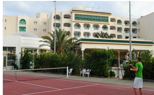
Figure 32:hôtel avec terrain de tennis .source : manelvoyages.tn
