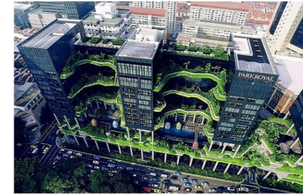
Figure 28 :Jardins de ciel en cantilevering à chaque quatrième niveau.
