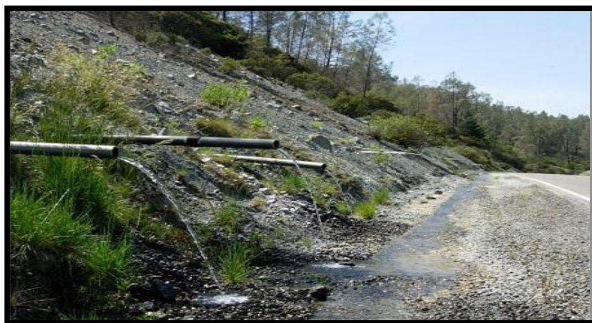
Figure 1- 35: Drainage de talus par barbacanes.
