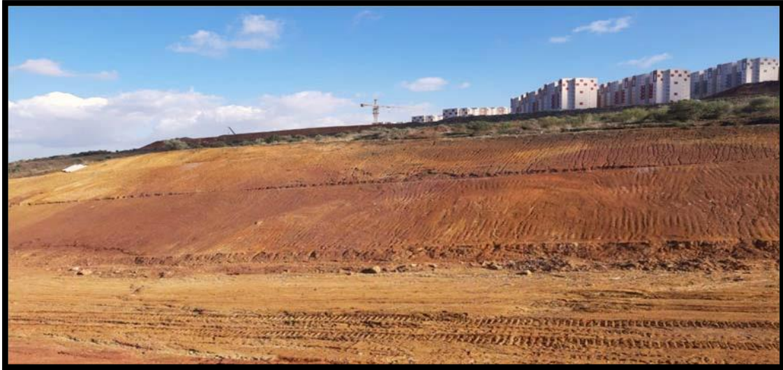
Figure 5- 1: Vue général de la zone de glissement (côté aval).
