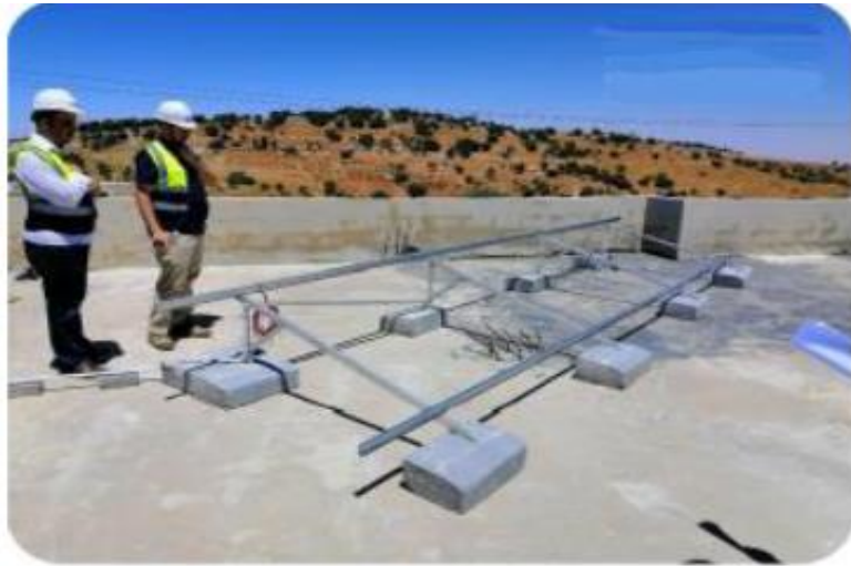
Figure 37 : La structure est en aluminium ou en alliage d'aluminium
