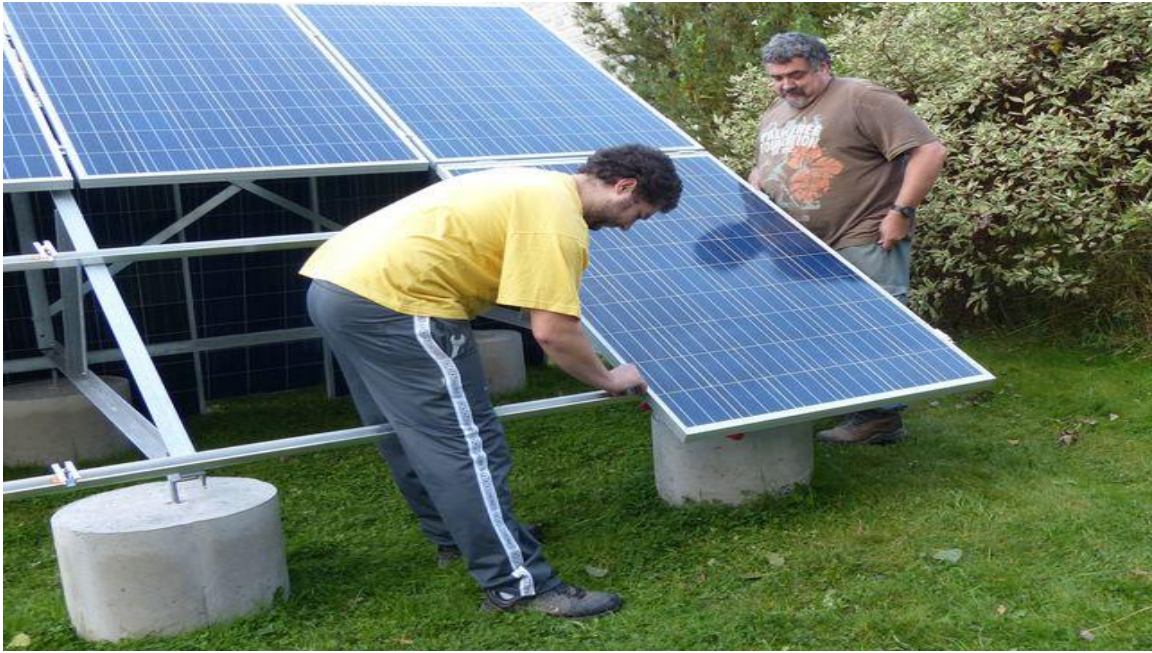
Figure 7 : Exemple de modules PV montés sur support fixe
