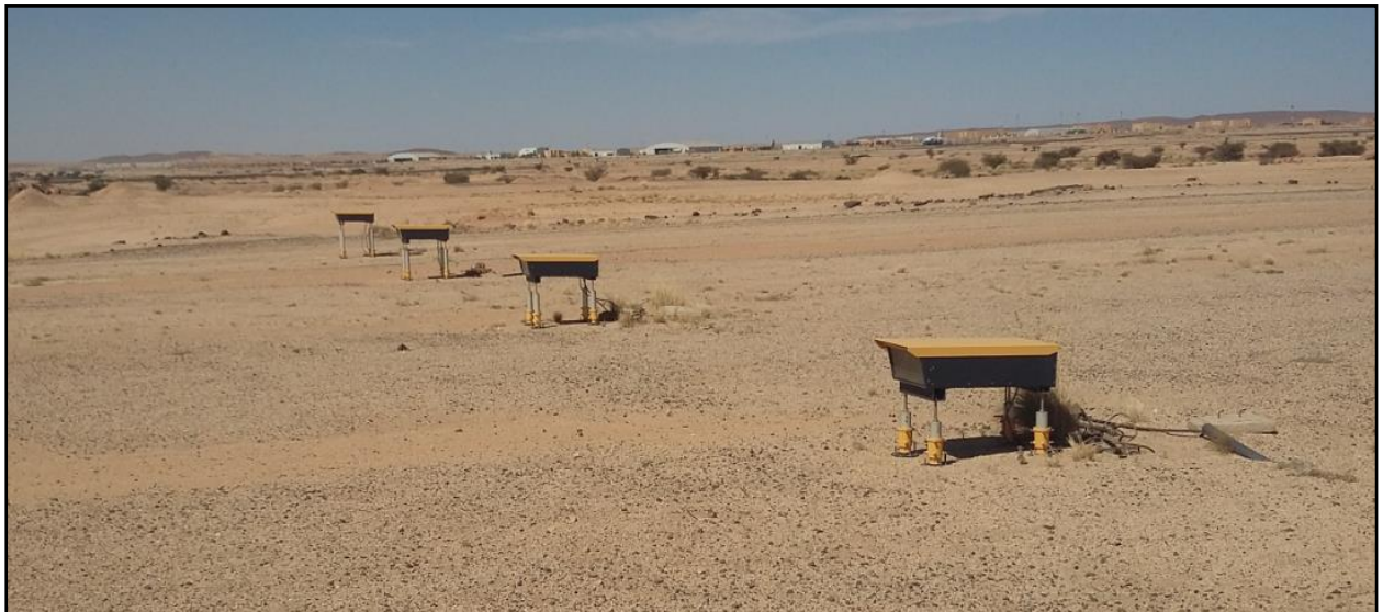
Figure 2.12 : indicateur de pente PAPI. [4]
