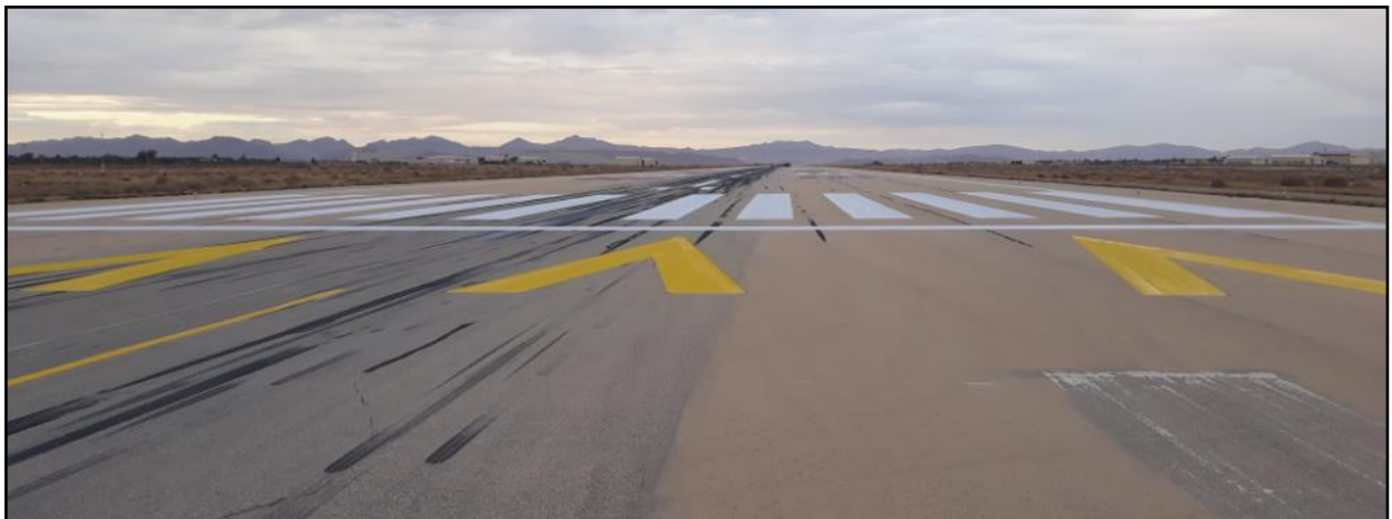
Figure 2.16: Marques de seuil 31 décalé de la piste.
