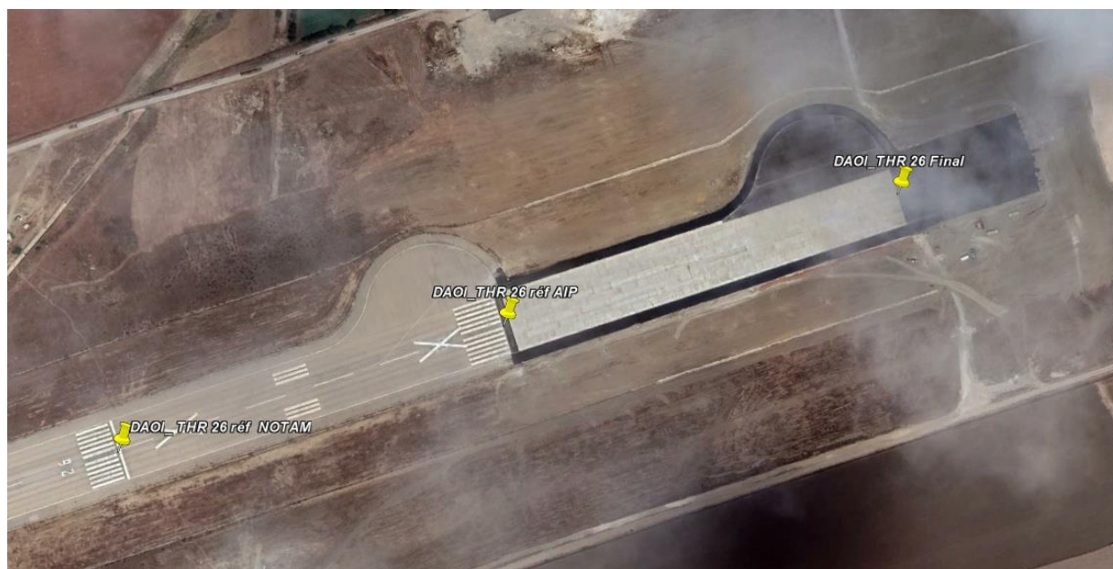
Figure 4 .4 : Image satellitaire du bout bétonné 26 en cours de réalisation.
