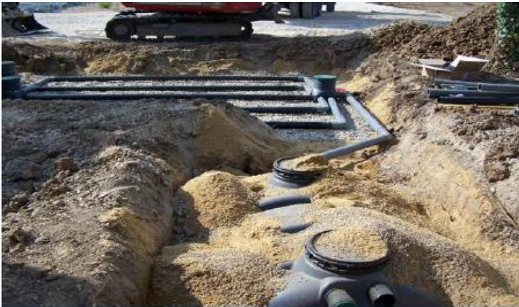
*Fig.3.16.installation du système decanteur-digesteur*
