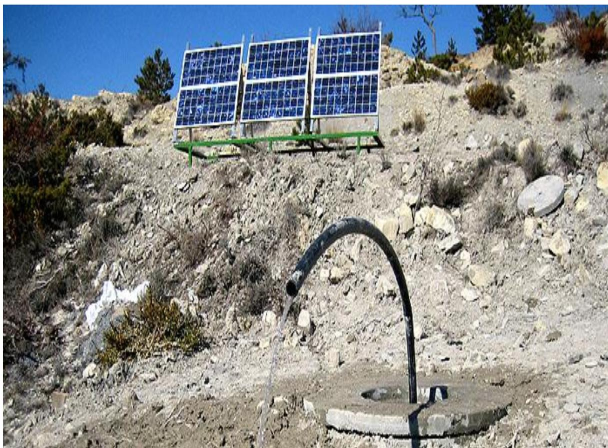
*Fig.3.21. pompe écologique utilisant l'énergie solaire*
