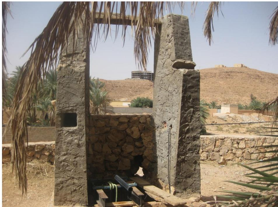
*Fig.3.11. puits traditionnel restauré avec des matériaux locaux*
