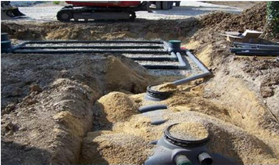
*Fig.3.16.installation du système decanteur-digesteur*
