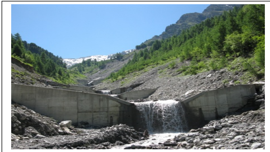
Figure 21 : Correction torrentielle dits de « consolidation » implantés dans le chenal d'écoulement [33]
