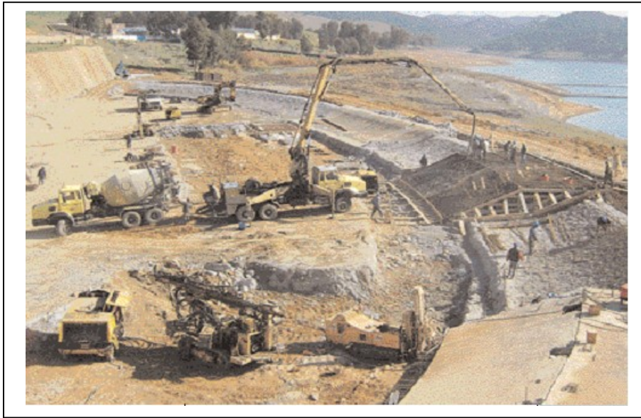
Figure 25 : Chantier de surélévation du Barrage de Ghrib [36]
