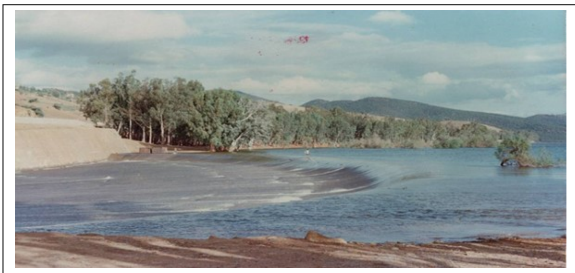
Figure 7 : Déversoir de Craeger du barrage de GHRIB (avant surélévation)
