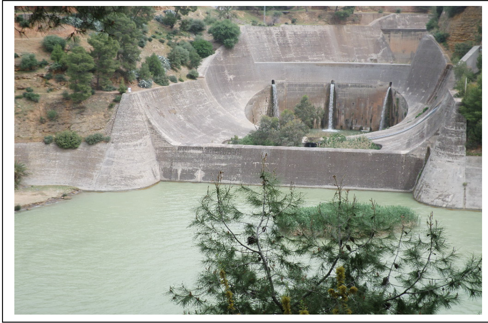
Figure 10 : Vue aval du barrage, Evacuateur de crue [14]
