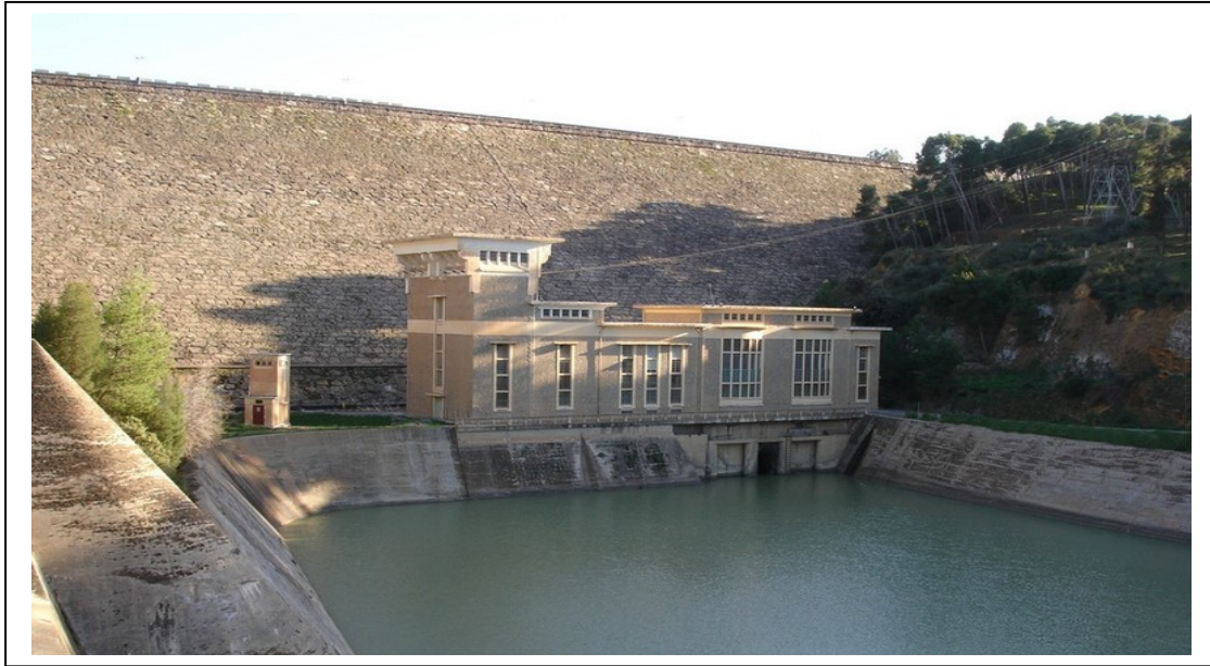
Figure 12 : Centrale Electrique du Barrage de Ghrib [13]
