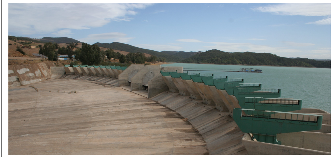
Figure 8 : Rive droite du Déversoir du Barrage de Ghrib, après surélévation [8]
