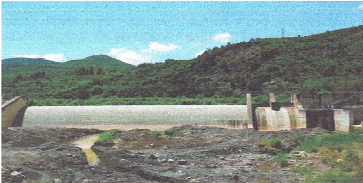
Photo N°1-2 : Déficit en sédiments grossiers à l'aval du seuil sur l'oued Cheffa -cas de la dérivation de Hamdania. ( Chanane Y.K., 2013 )
