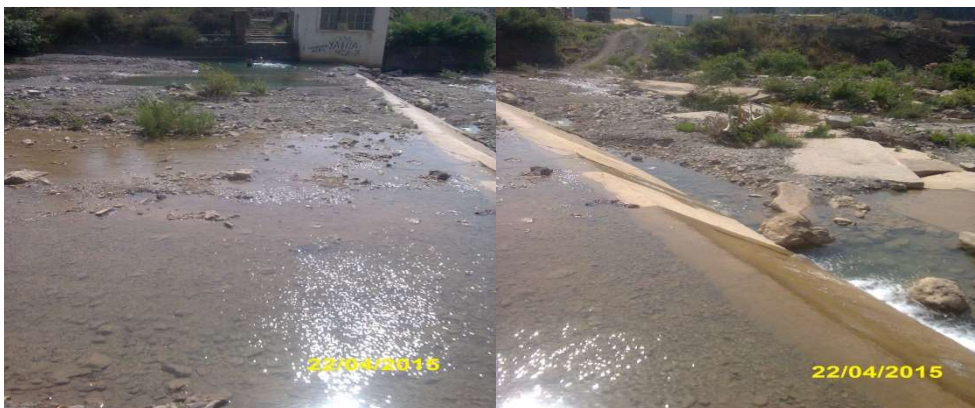
(a) Amont du seuil secondaire (b) Aval du seuil secondaire
