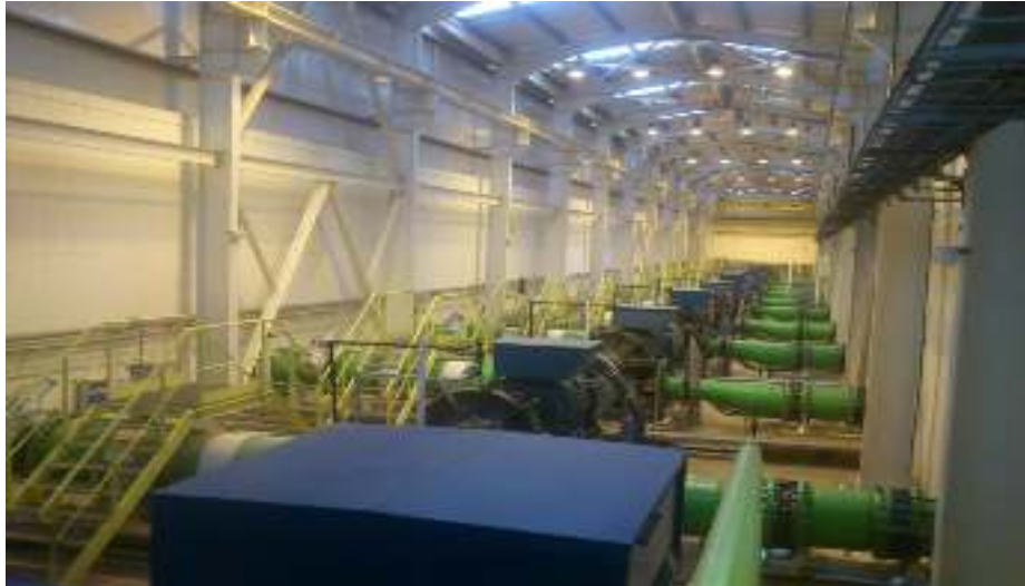
Figure III.9: Pompage intermédiaire (mai 2018)
