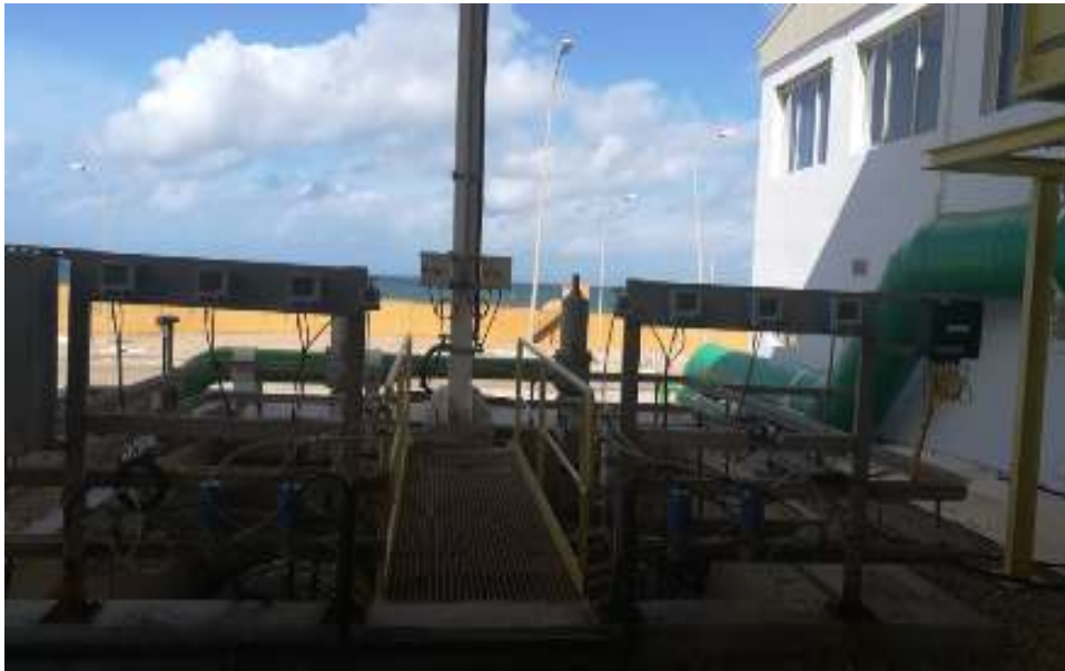
Figure III.11: Contrôle de qualité de l'eau filtré (mai 2018)
