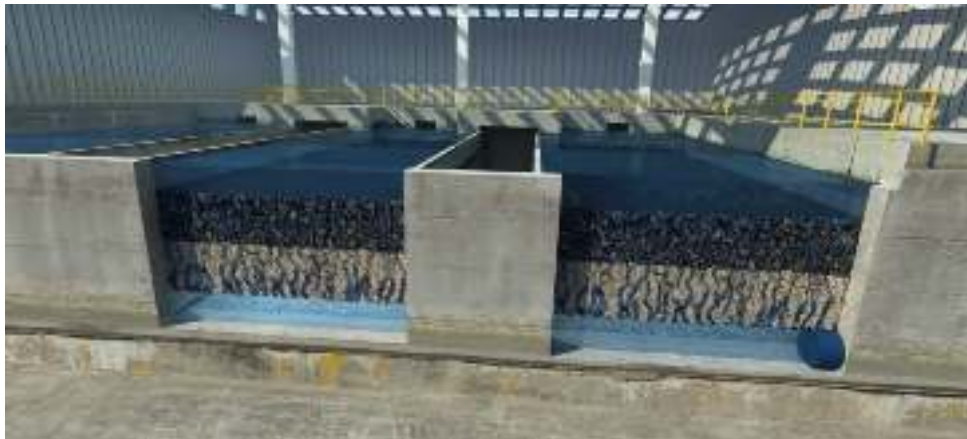
Figure III.7: Image explicative d'un filtre à sable. [38]
