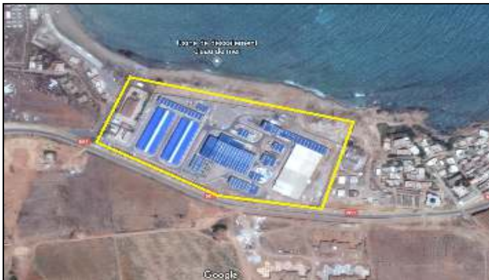
Figure III.2: Photo satellitaire de la station de Ténès. [34]
