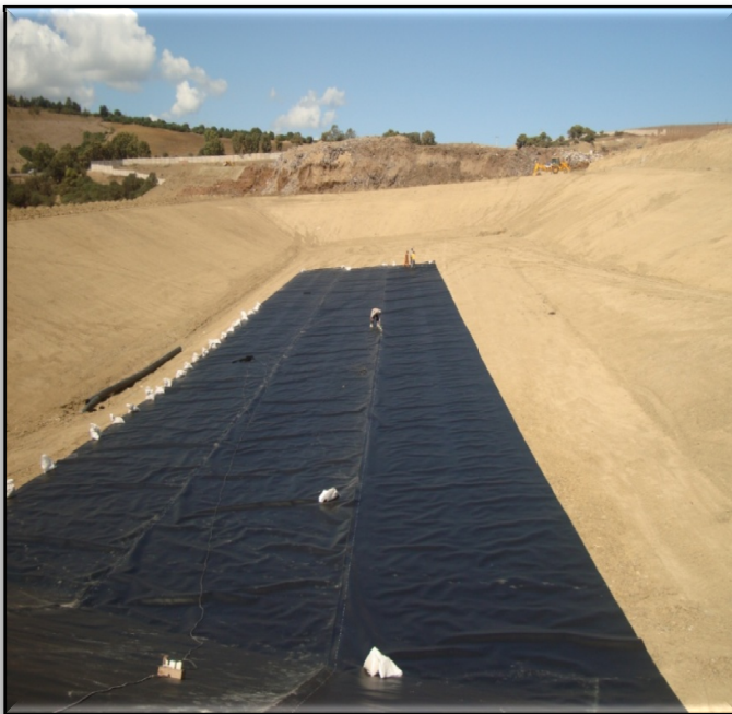
Photo06 : Aménagement du casier (pose de géomembrane)
