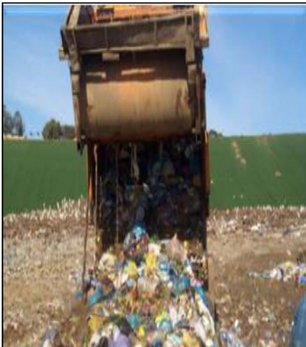
Photo14 : déchargement des déchets au niveau photo14: Etalage et compactage des Du casier déchets
