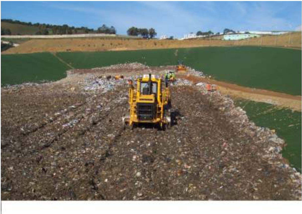
Photo 16 : Recouvrement des déchets
