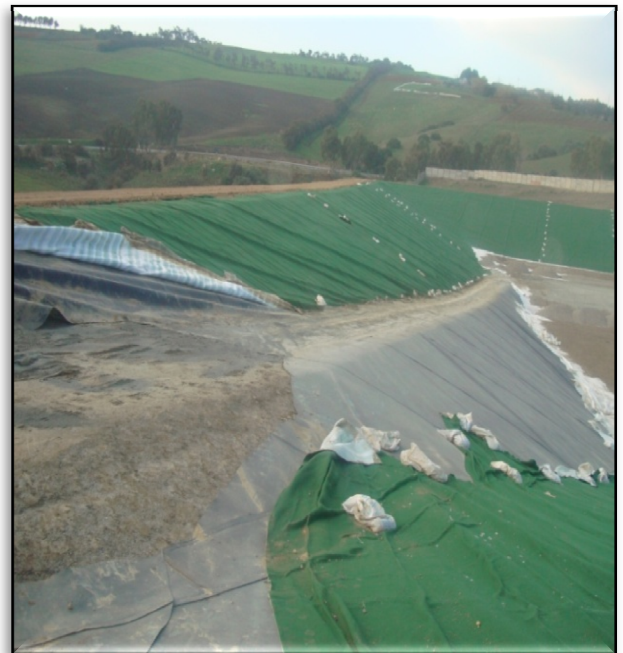
Photo 07 : Aménagement du casier (pose de géotextile)
