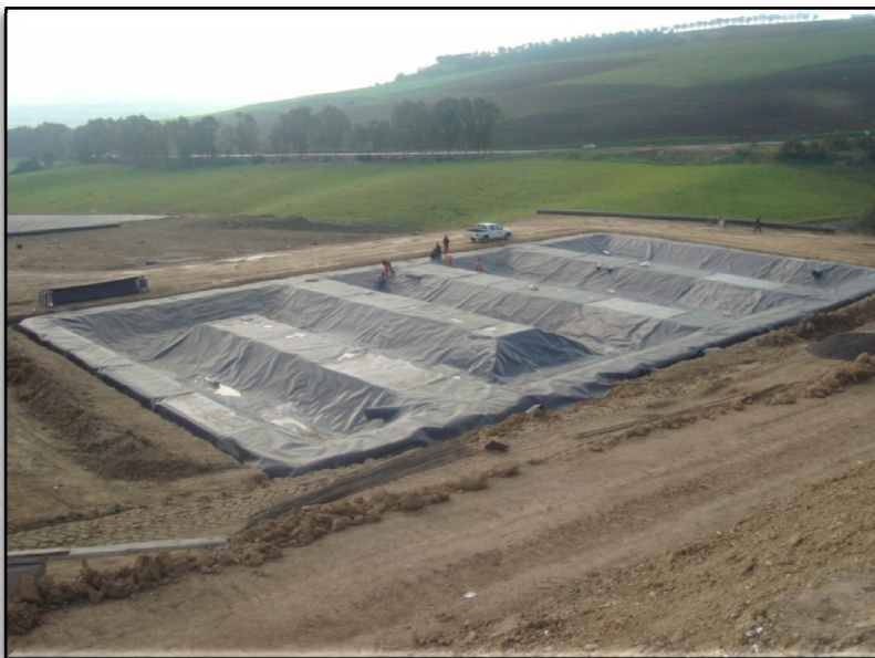
Photo 08 : Aménagement du bassin de récupération des lixiviats
