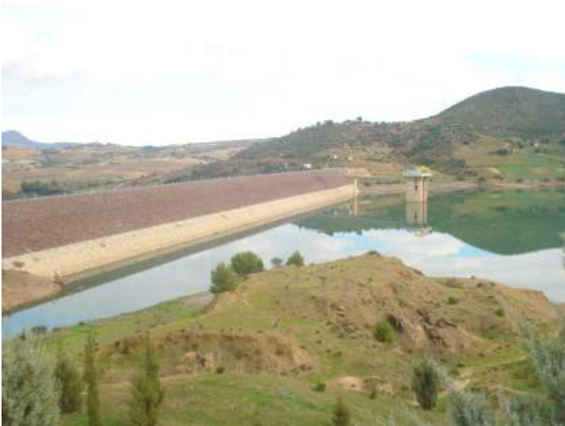
Fig.3.5. Une vue générale sur la retenue du barrage de Boukourdane (Remini 2016)
