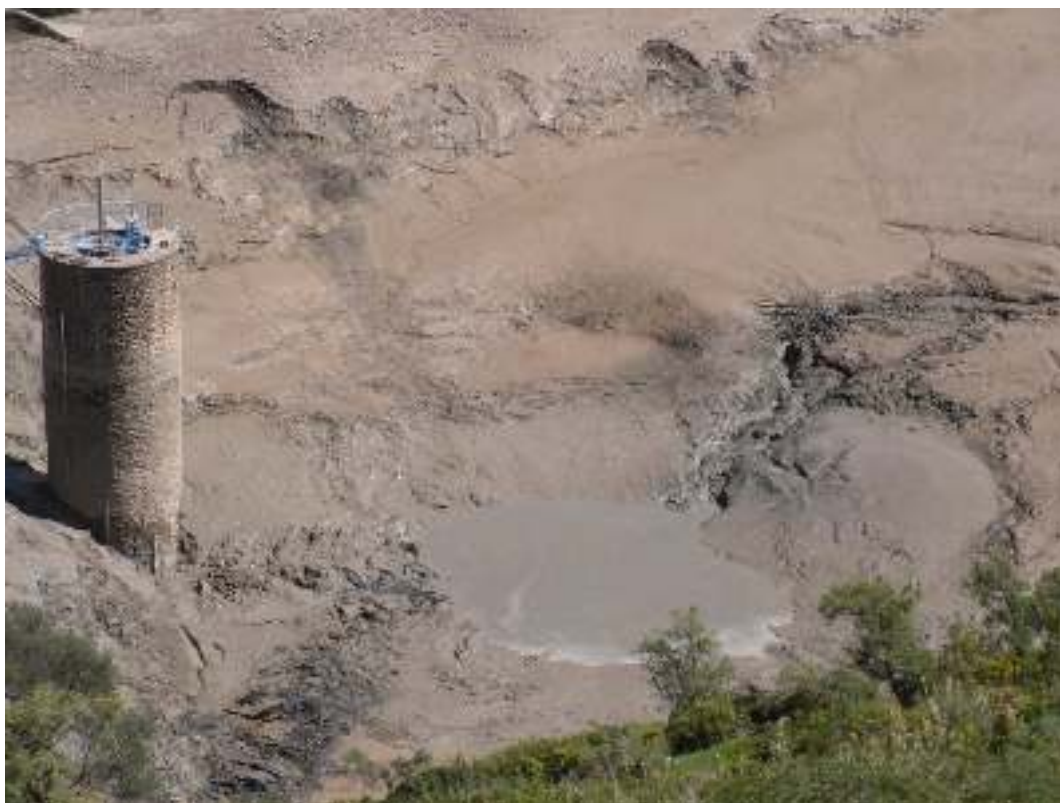
Fig.3.20. la retenue de barrage après la vidange[11]
