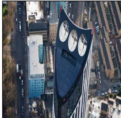
Figure 111: Eolienne de la tour de strate London.
