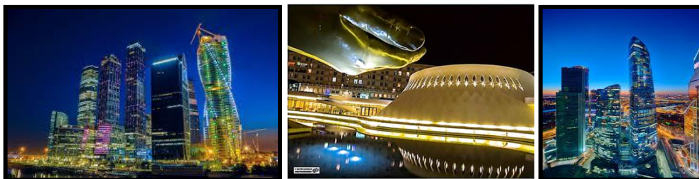
Figure 89 : Exemples d'éclairage extérieur des tours dans le monde.
