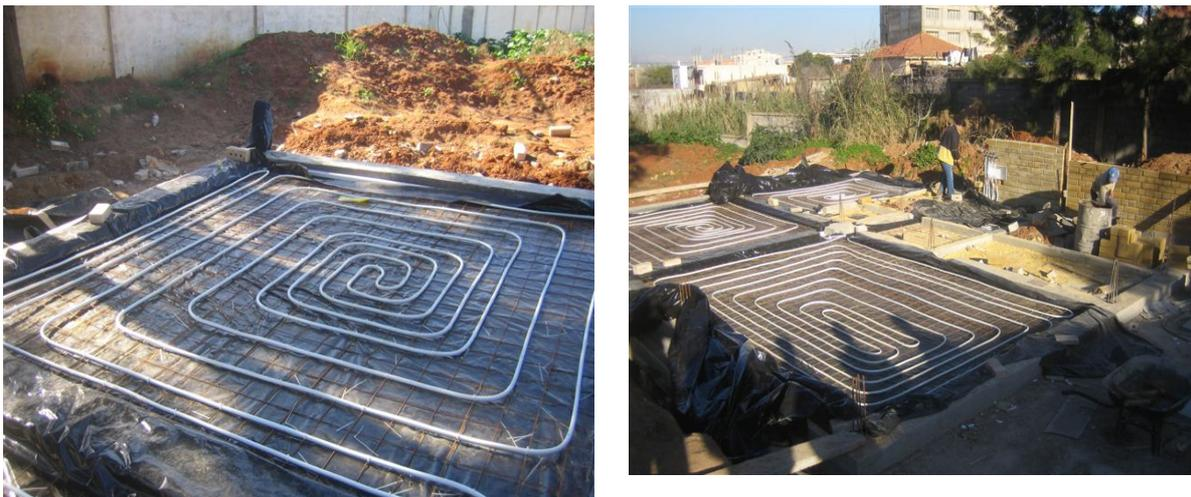
Figure. 2.8 Emplacement du escargot lors de la construction
