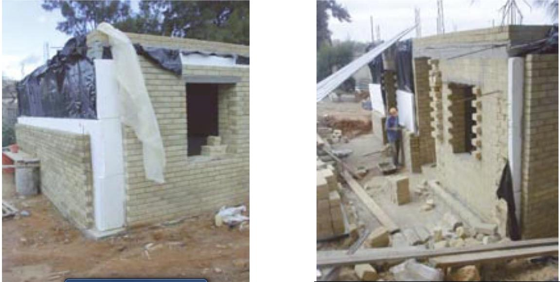
**Figure. 2.9** Isolation des murs extérieurs
