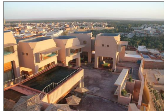
Figure 31 : Vue générale sur Dar Hi
