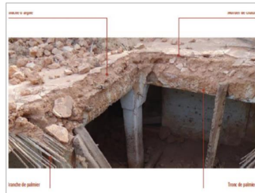
Figure 172 : Composants du plancher. Source : Slide Player, construction mixte acier et béton.
