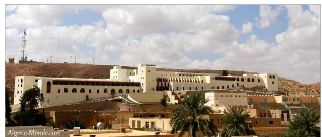
Figure 62 : vue sur l'hôtel du Mzab Source : Google Image.
