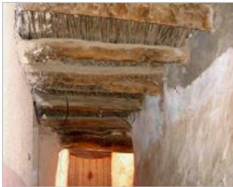
Figure 172 : passage couvert dans le Ksar. Source : auteurs.
