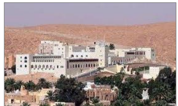
Figure 61 : vue sur l'hôtel du Mzab Source : Google Image.
