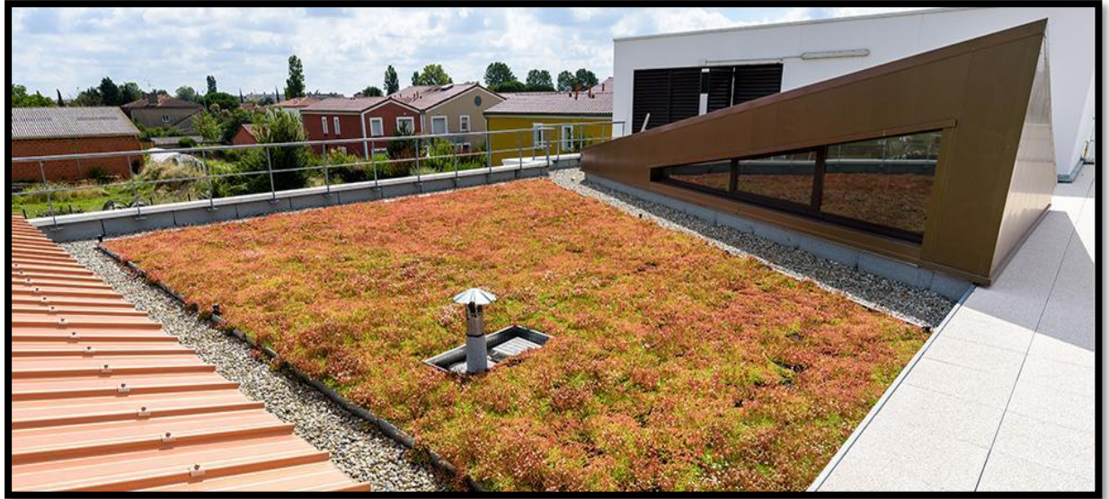
Figure 84 : Toiture végétalisée extensive.
