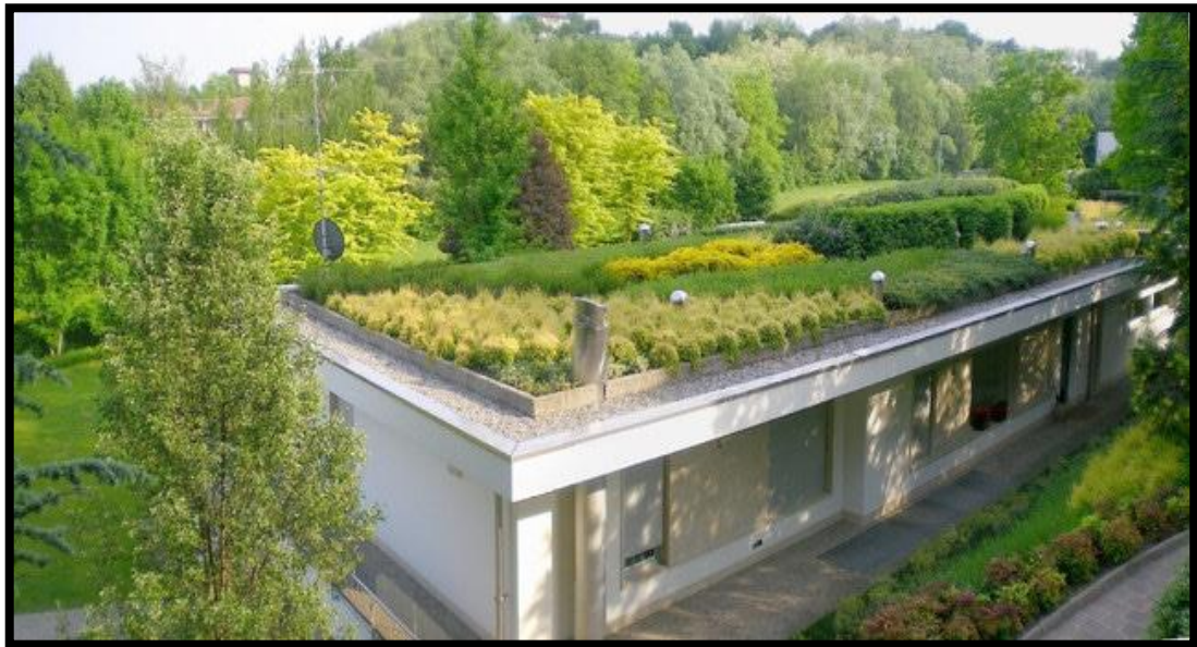
Figure 85 : Toiture végétalisée intensive.
