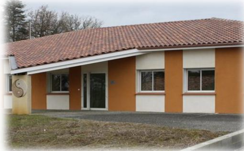
Figure 24 : Vue extérieure du projet.
