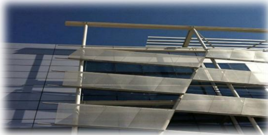
Figure 19 : Façade du projet.
