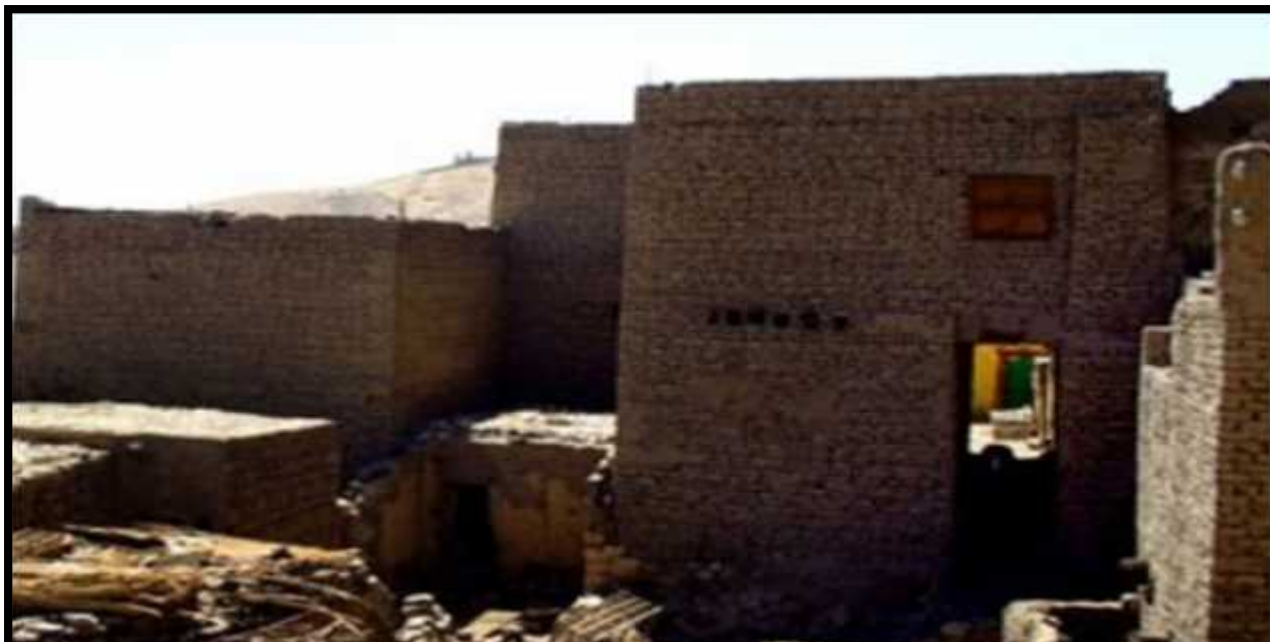
La construction en adobe avec l'argile comme enduit.
