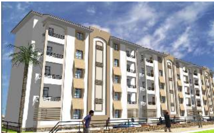
Figure 2.9. Façade du bloc à étudier (source : l'OPGI Blida)
